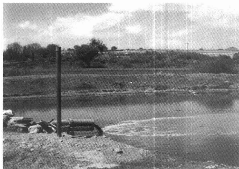
Laguna de oxidación
