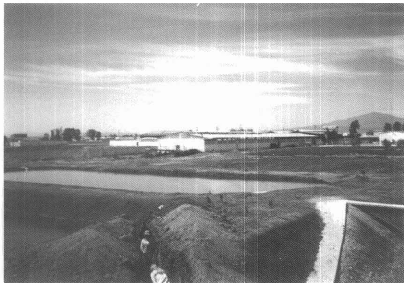
Laguna de oxidación
